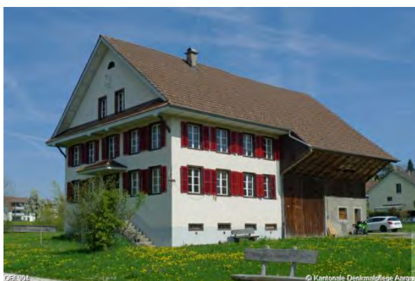
Gerberhaus (Quelle: Online-Inventar der Kantonalen Denkmalpflege Aargau)
